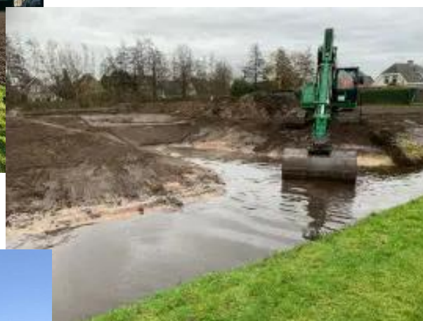
Sloten verbreden en een wadi graven
