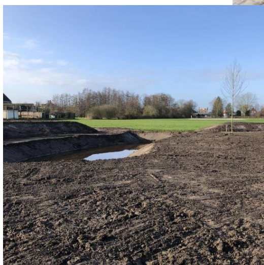
Sloten verbreden en een wadi graven
