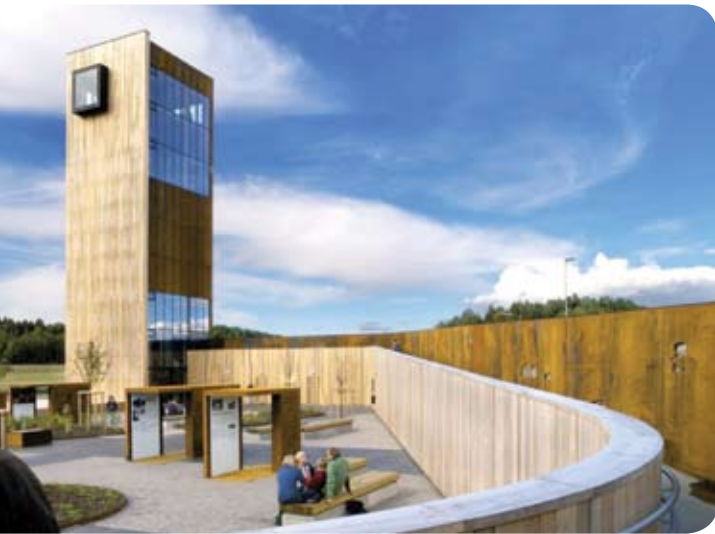
8. Een 'landmark' op de kop van de vismijn, een uitkijktoren richting de Zeelandbrug.
