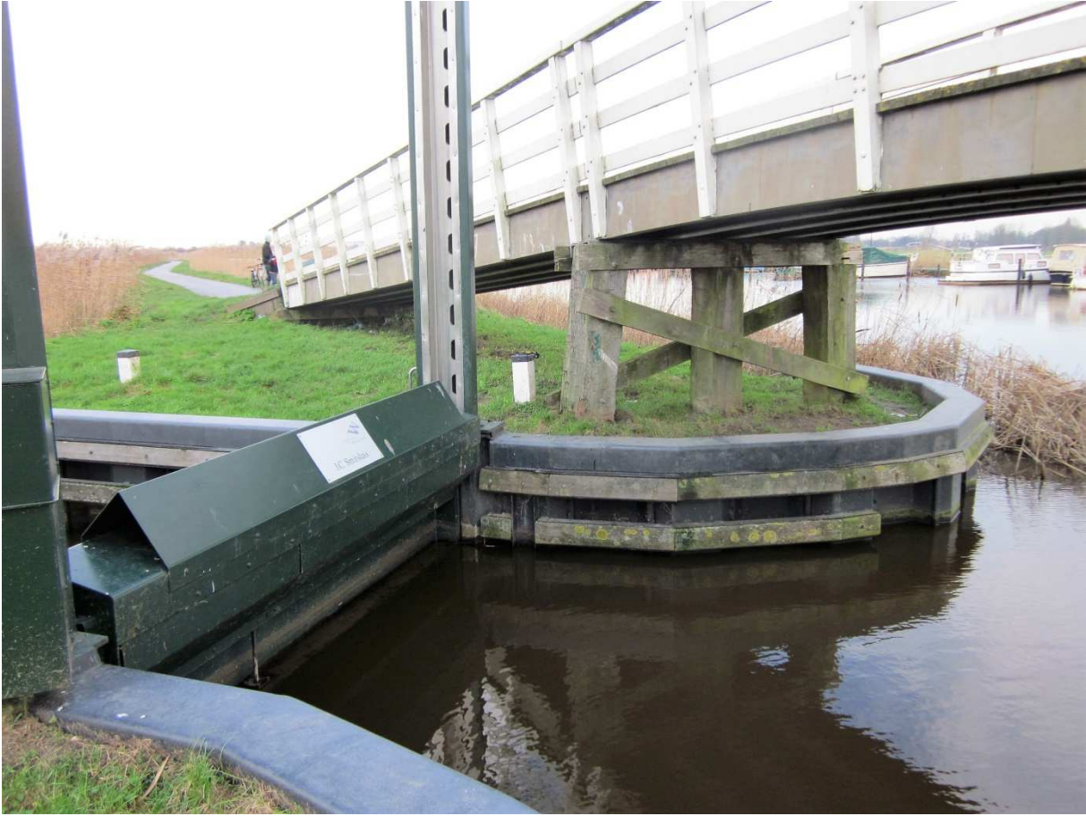
Bijlage 2 Foto overzicht van de sluis Middelkade
