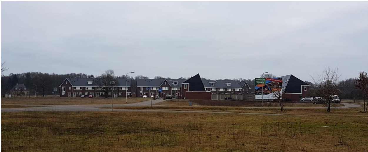
Figuur 1: Huidige situatie gezien vanaf de Dennenweg.
