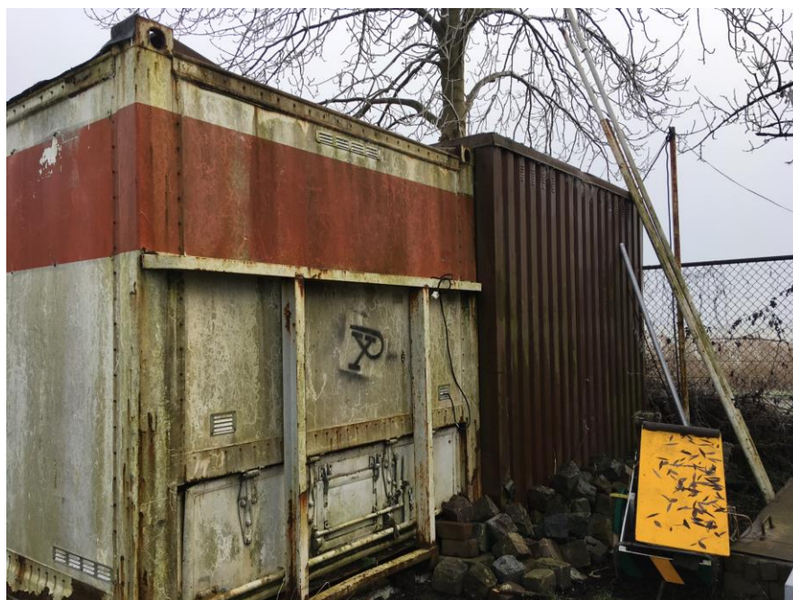
Afbeelding 11: De zeecontainers zijn lek en de ruimte erachter een gribus
